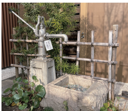
〔東京都 浄名院 上野さくら浄苑〕 地域住民の防災用水対策として。
