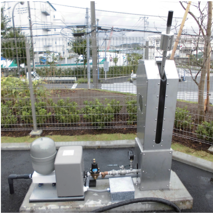
※写真は据付参考写真です。
