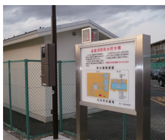
機材倉庫外観
