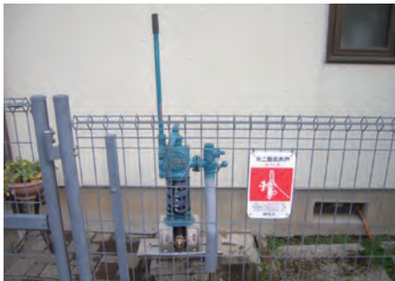
[東京都 個人宅] 生活用水・給水・初期消火活用計画として。
