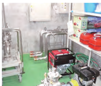
倉庫内配備状況
