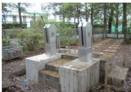
[東京都練馬区 S公園] 防災用トイレ配管システム・樹木への水やりとして。
